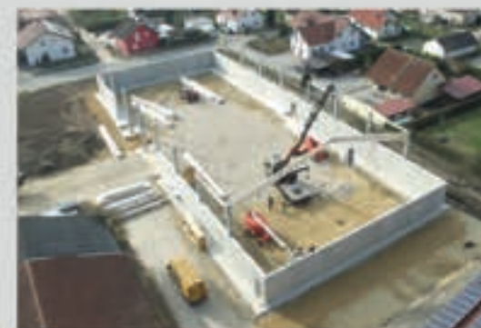
➤ Montaż konstrukcji ramowej na ścianie oporowej
