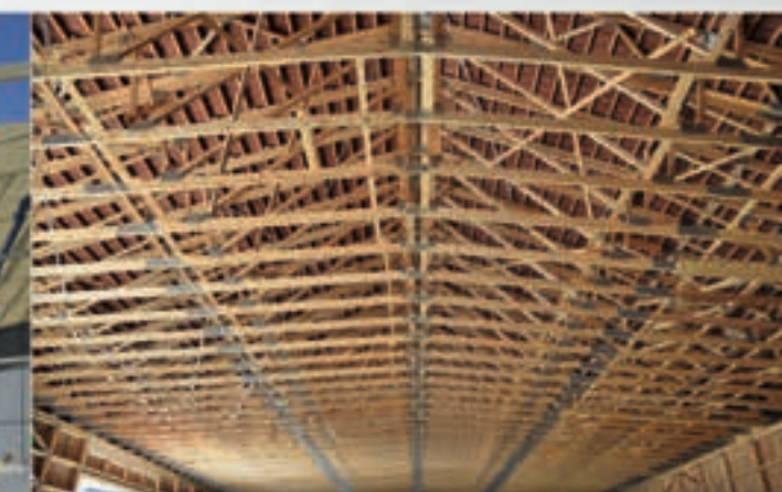
WIĄZARY ŁĄCZONE PŁYTKAMI KOLCZASTYMI
