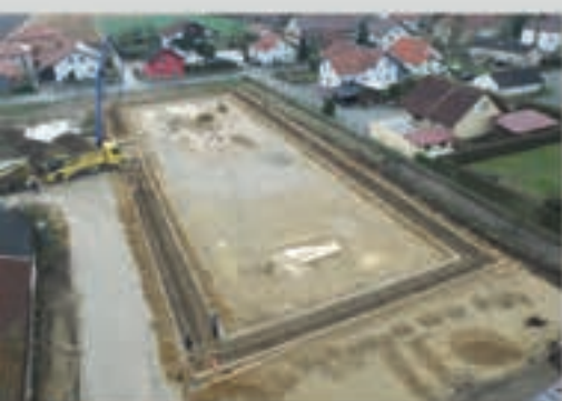
➤ Zbrojenie i betonowanie ław fundamentowych
