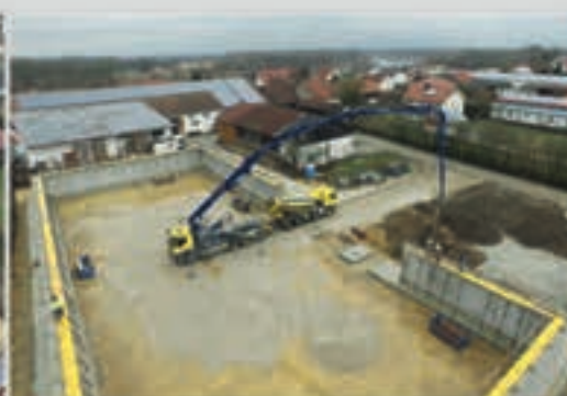
➤ Wypełnienie betonem prefabrykowanych ścian oporowych
