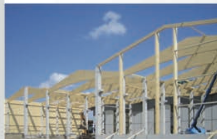
WIĄZARY ŁĄCZONE PŁYTKAMI KOLCZASTYMI
