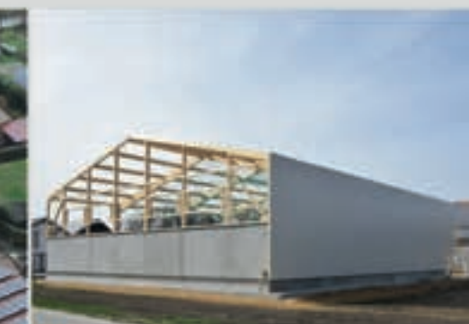
➤ Montaż okładzin ściennych z płyt warstwowych
