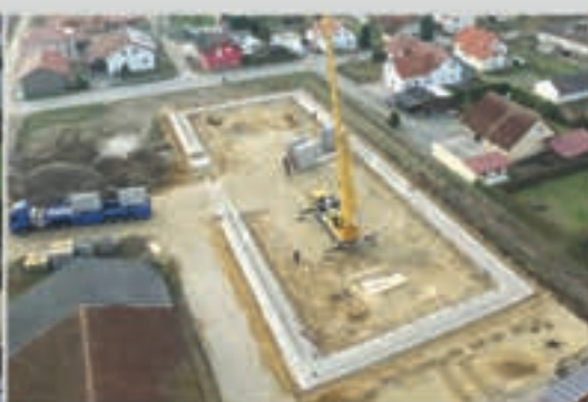
➤ Dostawa i montaż prefabrykowanych elementów betonowych ścian oporowych
