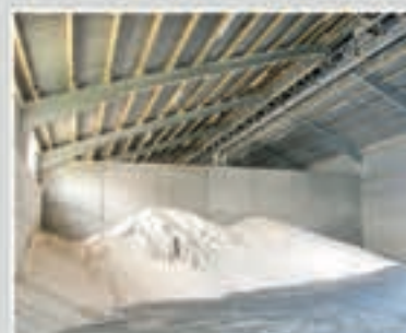
Magazyn na nawóz- ściana zasypowa
