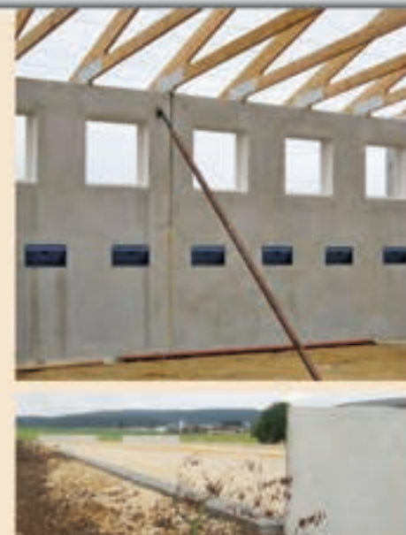
Ławy fundamentowe pod prefabrykowane betonowe elementy ścienne
