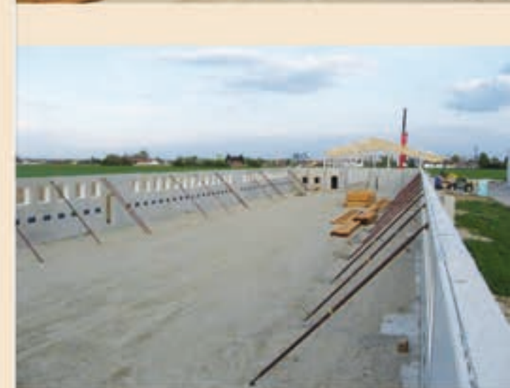
Ławy fundamentowe pod prefabrykowane betonowe elementy ścienne
