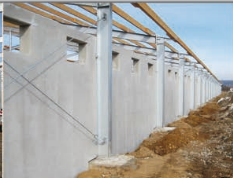
Stopy fundamentowe pod słupy ram stalowych i prefabrykowanych ścian betonowych
