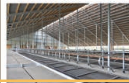
Rama stalowa (ze słupami pośrednimi)
