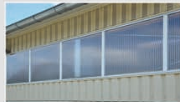
Elewacja z blachy trapezowej
