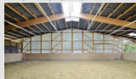
Wentylacja z blachy perforowanej w ścianie szczytowej
