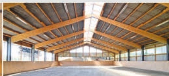
Ściana szczytowa w konstrukcji szkieletowej drewnianej, konstrukcja ramowa typu stal- drewno klejone, płatwie zakładkowe drewniane z pokryciem dachu płytą włókno- cementową i świetlikiem dachowym kalenicowym, okładzina ścienna z blachy stalowej trapezowej, dodatkowe powierzchnie wentylacyjno- doświetleniowe
