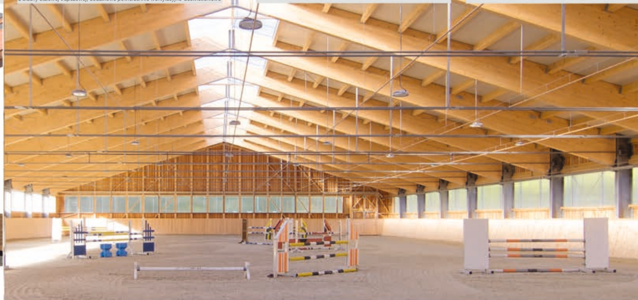
Ściana szczytowa w konstrukcji szkieletowej drewnianej, konstrukcja ramowa typu stal- drewno klejone, płatwie zakładkowe drewniane z pokryciem dachu płytą włókno- cementową i świetlikiem dachowym kalenicowym, okładzina ścienna z blachy stalowej trapezowej, dodatkowe powierzchnie wentylacyjno- doświetleniowe
