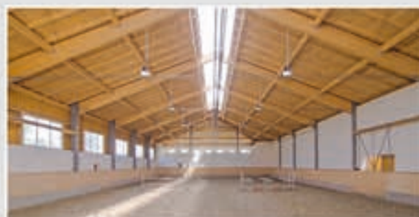
Rama typu stal- drewno klejone ze ściągami, dach krokwiowy z pokryciem dachówką, świetlik w kalenicy, ściany wykonane z prefabrykowanych elementów betonowych malowanych na biało lub obite drewnem
