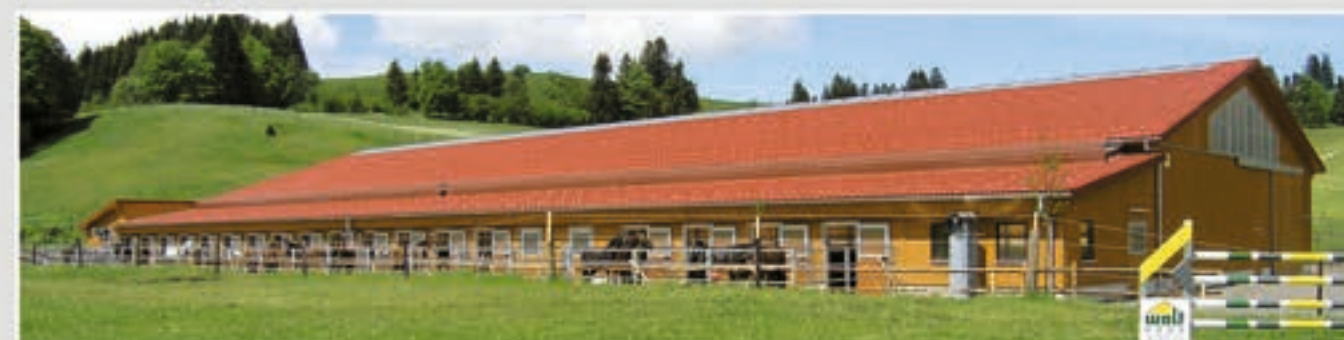
Konstrukcja ramowa stalowa ocynkowana ze ściągiem, płatwie zakładkowe z pokryciem dachowym wykonanym z płyt włókno-cementowych, ściany zewnętrzne z okładziną drewnianą.
