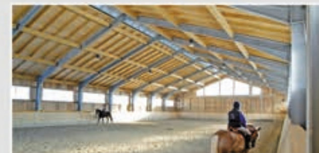
Konstrukcja ramowa stalowa ocynkowana bez ściągu, dach pokryty dachówką, okładzina ścienna z drewna.
