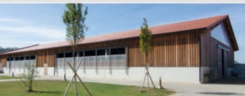
Wentylacja w ścianie podłużnej za pomocą kurtyny poliwęglanowej
