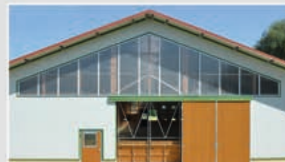
Elewacja z płyty warstwowej
