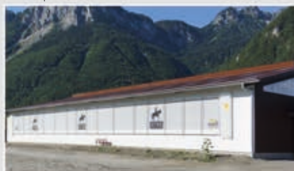
Wentylacja w ścianie podłużnej za pomocą zwijanej kurtyny z tkaniny
