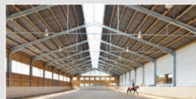
Konstrukcja ramowa stalowa ocynkowana ze ściągiem, płatwie zakładkowe z pokryciem dachowym wykonanym z płyt włókno-cementowych, ściany zewnętrzne z okładziną drewnianą.
