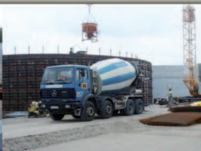
betonowanie ściany zbiornika
