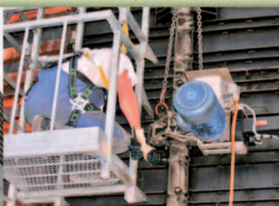
WOLF System systemy do bezpiecznej pracy: np. opatentowane urządzenie do rozszałowywania razem z koszem montażowym
