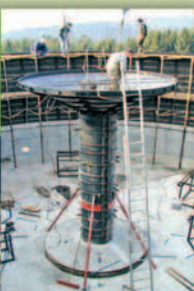
Detale: zabetonowany centralny słup grzybkowy
