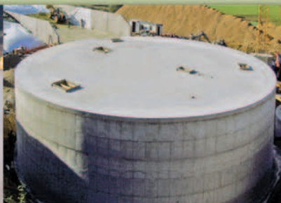
...gotowy zbiornik żelbetowy ze stropem
