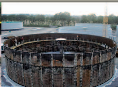
...prawie gotowa ściana z zaszalowaną podporą centralną
