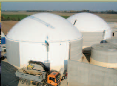
Specjalne warianty izolacji i przykrycia ściany oraz różnorodne nakrycia zbiornika, odpowiednie do celu zastosowania
