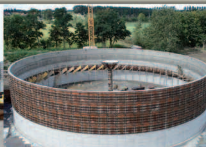
rozszałowywanie ściany zbiornika
