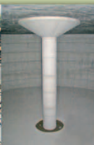
Detale: zabetonowany centralny słup grzybkowy
