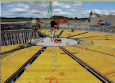
Rozkładanie prefabrykowanych elementów stropowych
