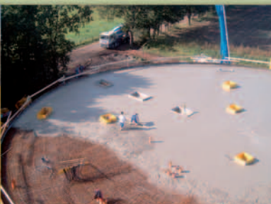
Zbrojenie i betonowanie stropu zbiornika
