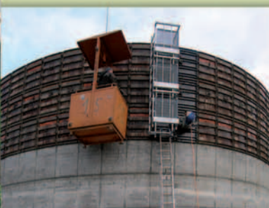
WOLF System systemy do bezpiecznej pracy: np. opatentowane urządzenie do rozszałowywania razem z koszem montażowym
